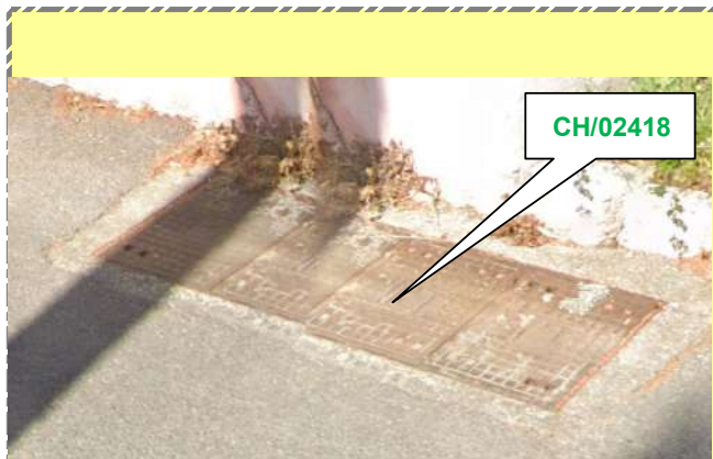
Photo de la situation de la chambre - CH/2418 au 1 avenue Saint-Pierre
