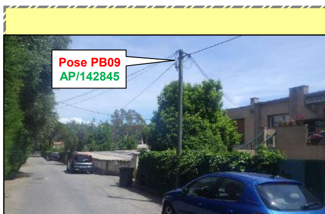
i Photo de situation de l'appui - AP/142845 au 22 T avenue Saint-Pierre
