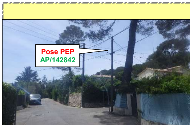
i Photo de situation de l'appui - AP/142842 au 25 avenue Saint-Pierre
