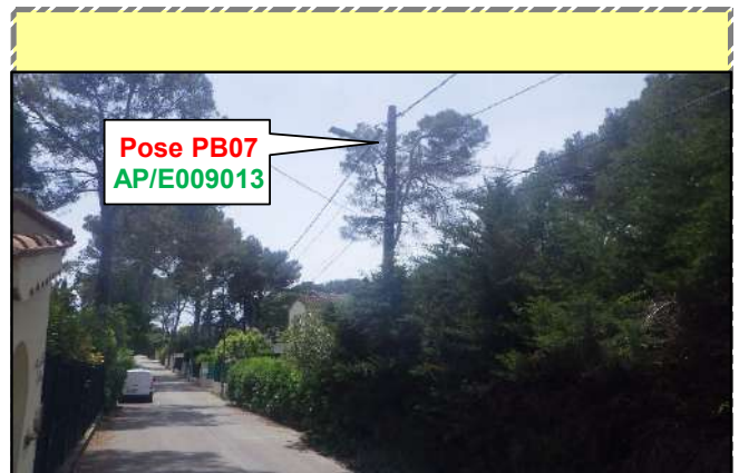
Photo de situation de l'appui - AP/E009013 au 2B avenue Charlotte
