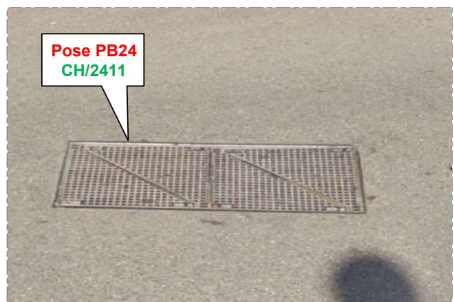
Photo de situation de la chambre - CH/2411 au 6 chemin de l'Aubarede
