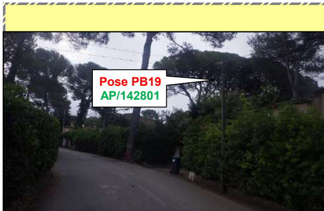
i Photo de situation de l'appui - AP/142801 au 7 avenue de l'Aubadere
