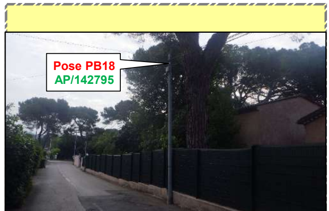
Photo de situation de l'appui - AP/142795 au 1 avenue de l'Aubarede
