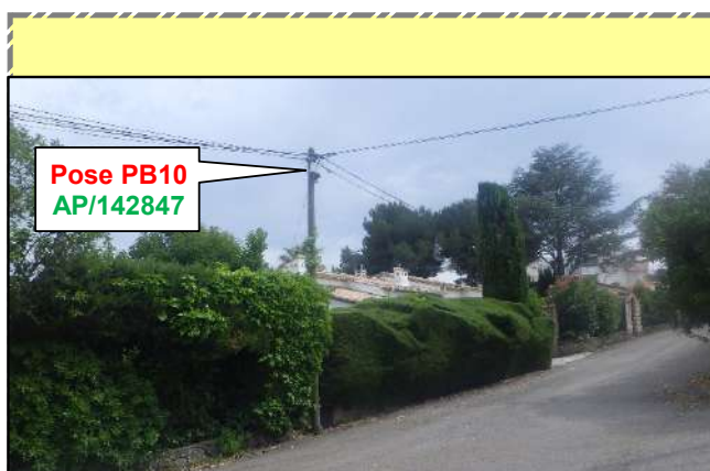
i Photo de situation de l'appui - AP/142847 au 31 avenue Saint-Pierre
